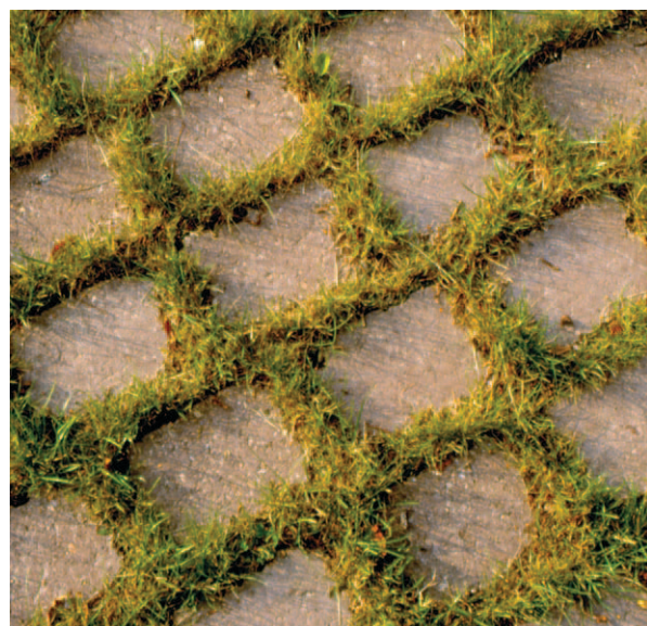
Pflastersteine lassen sich mit 2 cm Abstand zu Rasenpflaster verlegen. Regenwasser kann so versickern, niedrigwüchsige Wildkräuter finden eine ökologische Nische.
